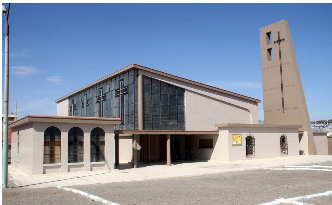
Vista de la Parroquia San Juan Bautista.
